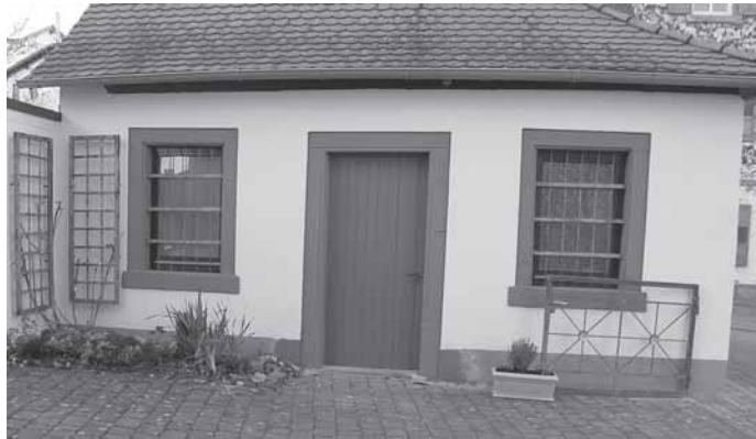
Das sanierte Waschhaus
